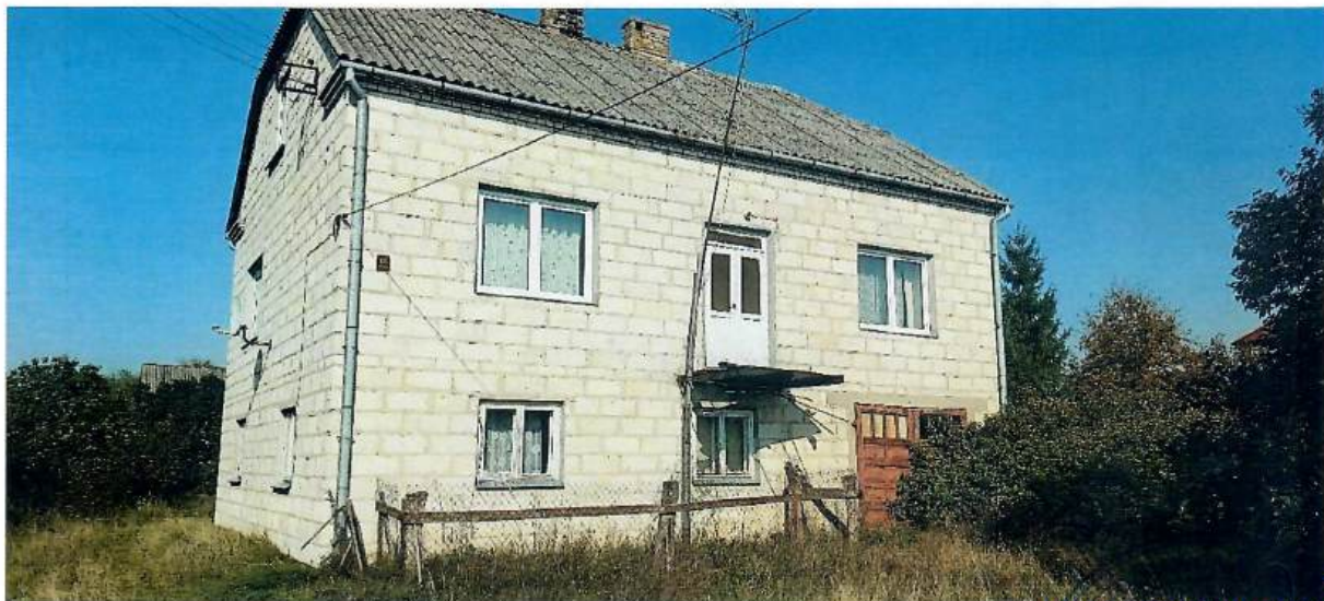
Foto. Widok budynku mieszkalnego, dz. nr 91/1 i 91/2.
